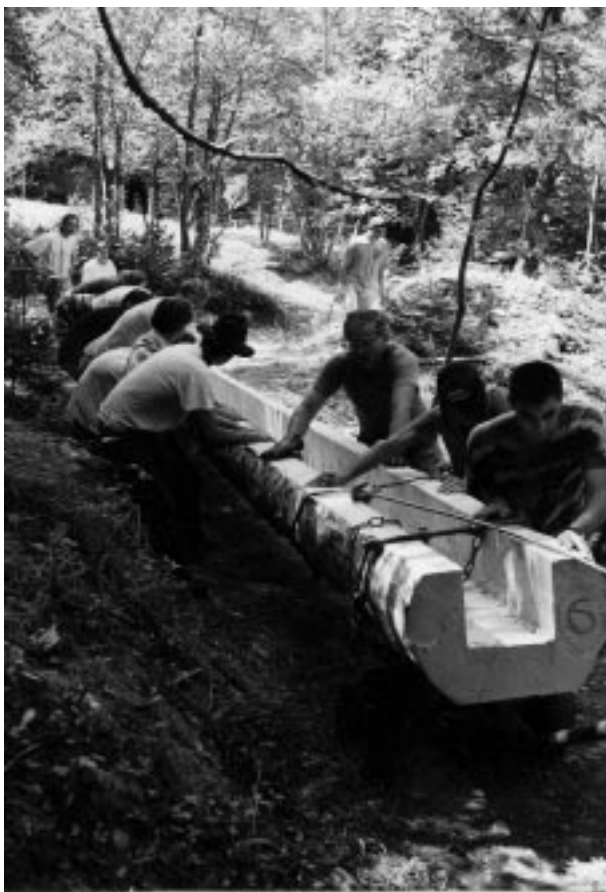
Chantier de rénovation de la scierie hydraulique avec l'association des Amis du patrimoine de Bellecombe : installation du bief.
